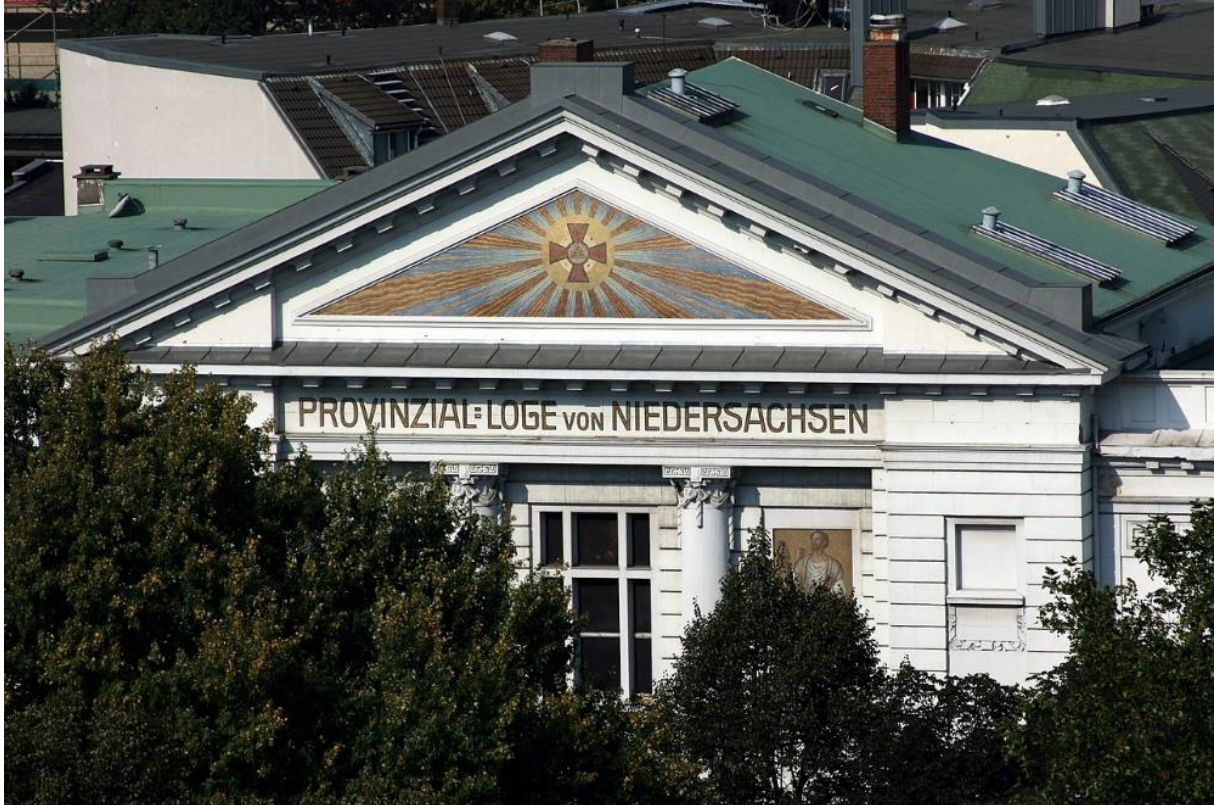
Provinzialloge von Niedersachsen in Hamburg, Logenhaus an der Moorweidenstraße
