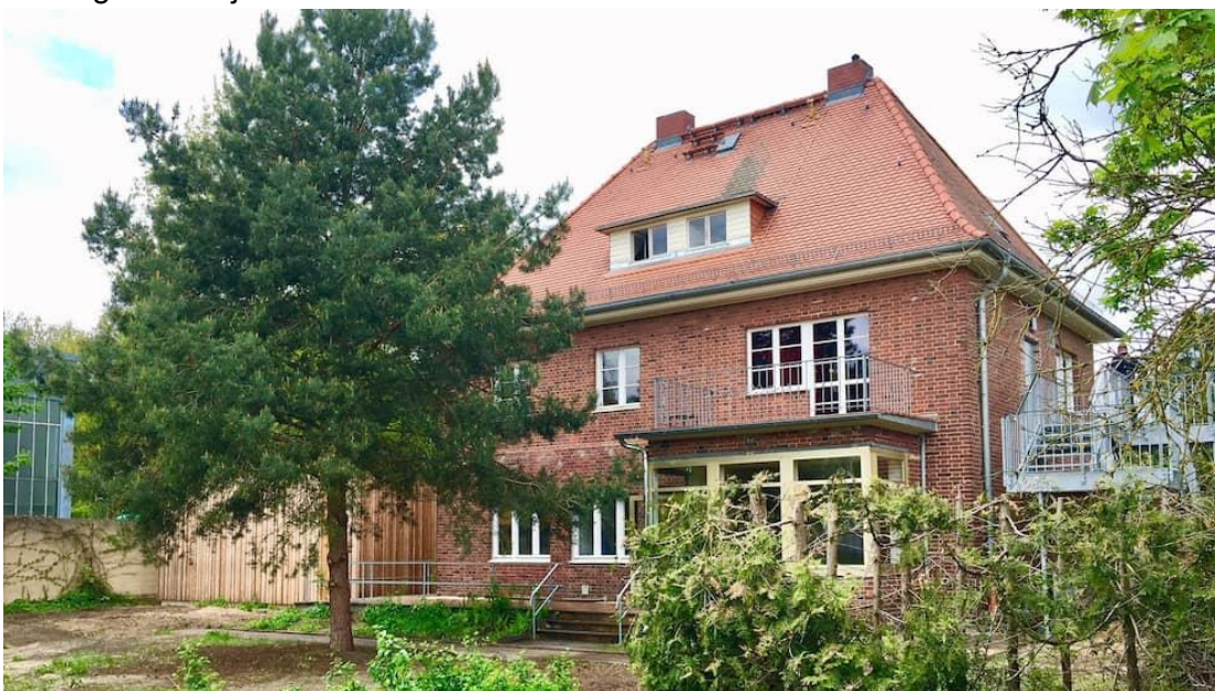
Die Dauerausstellung ist in der umgebauten Direktoren-Villa (Foto: Tomas Kittan tomas Kittan)
