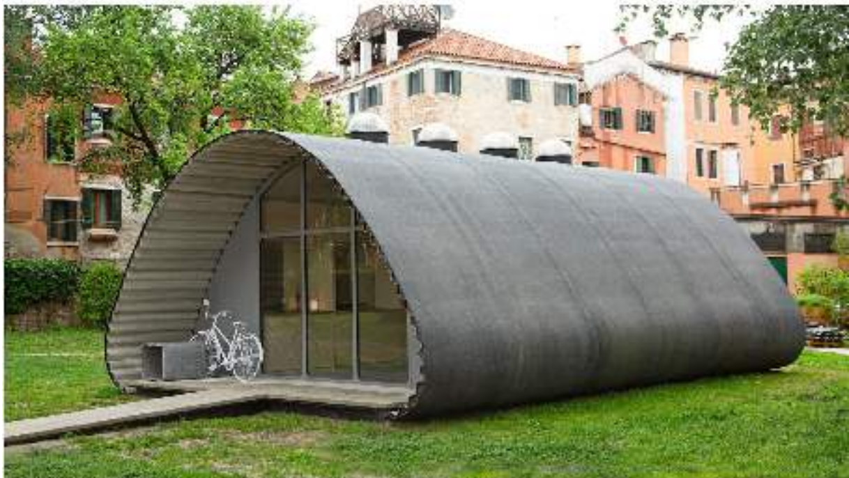
Das Haus ist ein Beispiel für die Integration von Nachhaltigkeit in die Architektur. Die Fassade ist aus recyceltem Aluminium gefertigt und das Gebäude verfügt über eine Solaranlage zur Energieerzeugung.
