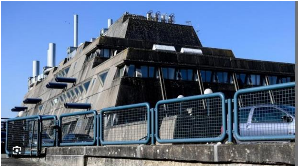
Architektur - Berlin - Denkmal oder Betonmonster: Was wird aus dem Mausebunker? - Kultur - SZ.de
