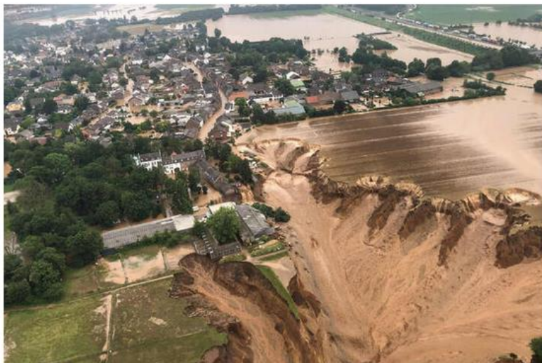
Das Gelände der Grube soll nun teilweise in ein Auengebiet umgewandelt werden, das Blessem künftig vor Überströmungen durch die Erft schützen soll. © Rhein-Erft-Kreis/dpa
