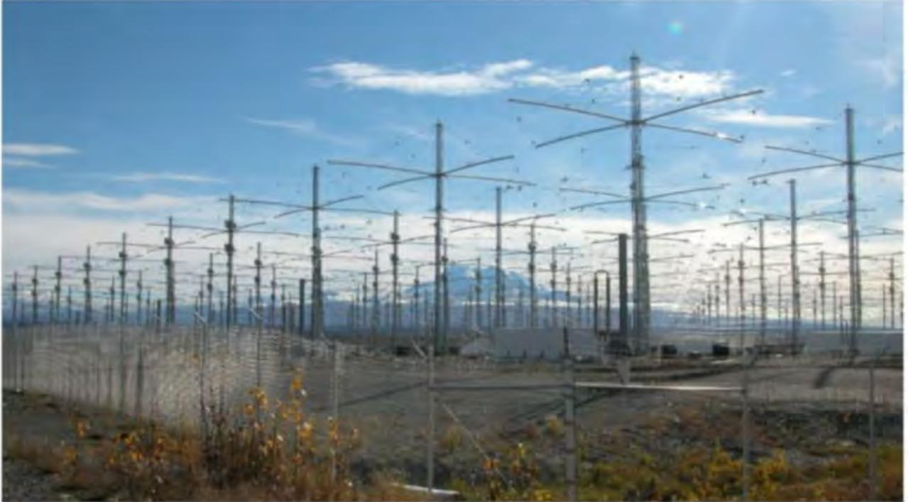
Das HAARP (englisch High Frequency Active Auroral Research Program) ist ein US-amerikanisches ziviles und militarisches Forschungsprogramm, bei dem Radiowellen zur Untersuchung der oberen Atmosphäre (insbesondere Ionosphäre) eingesetzt werden. *Foto: US Air Force*
