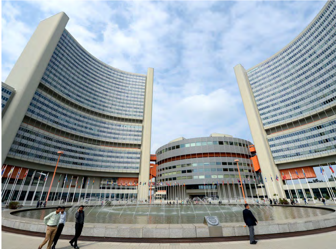
okkultes UNS-Gebäude in Wien
